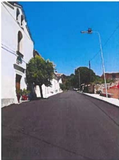
Strada Com. Convento
